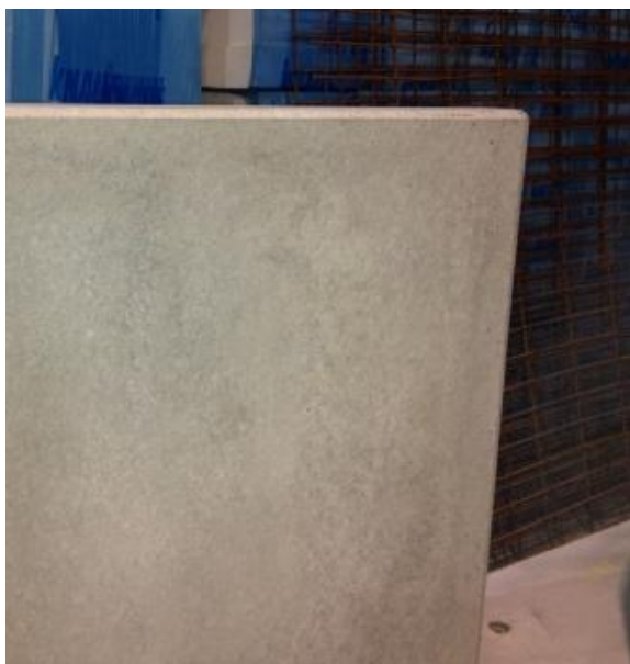
Aspect lisse coffrage
