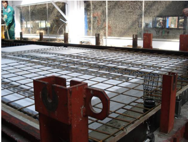
Pose treilli supérieur
